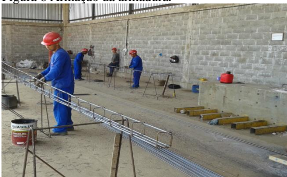
Figura 6 Armação da armadura.
