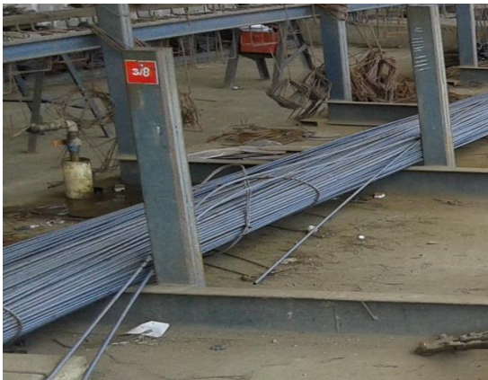
Figura 3 Armazenamento do aço
