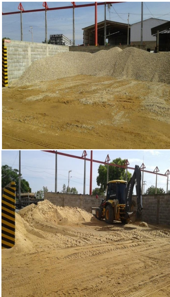
Figura 2 Armazenamento da areia e da brita.
