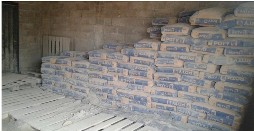
Figura 1 Armazenamento do cimento
