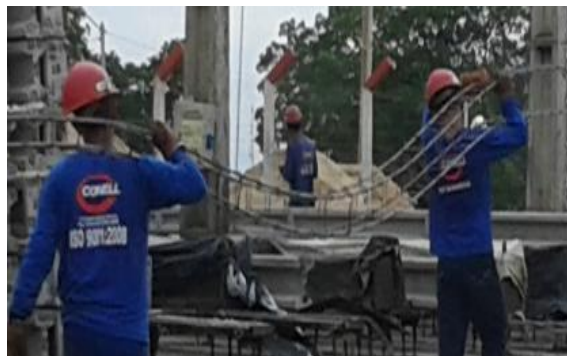
Figura 7 Transporte da armadura.
