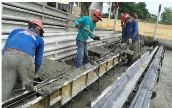
Figura 14 Processo de lançamento e adensamento
