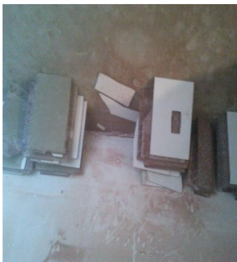
Figura 6 - Erros de cortes
