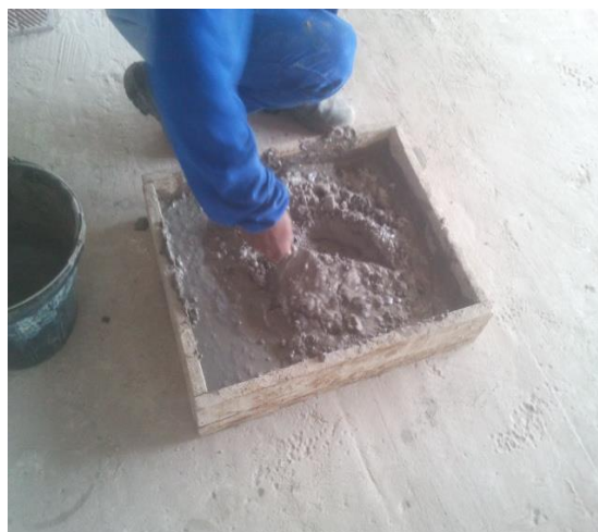
Figura 5- Preparo da argamassa
