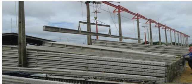
Figura 16 Armazenamento fora da secção duplo T.
